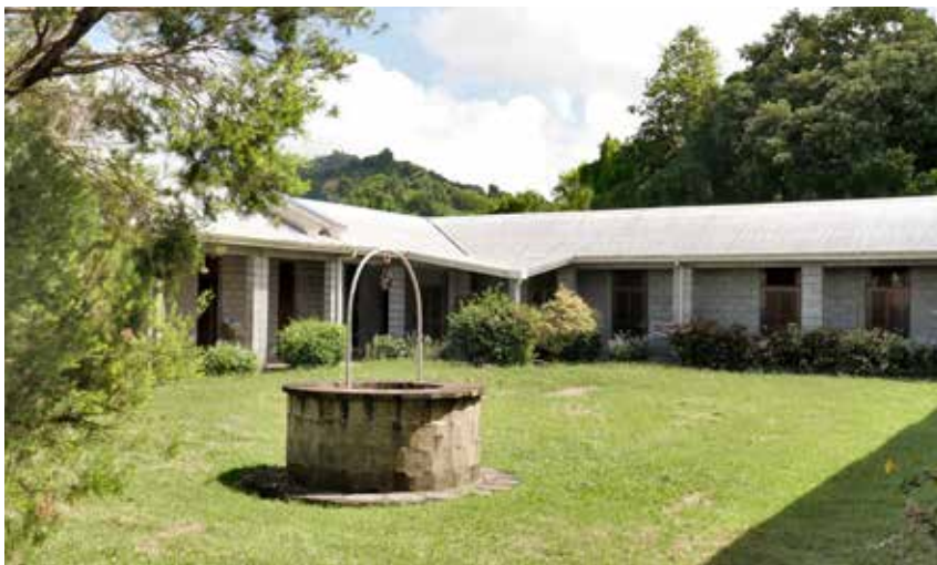
Quatre patios sont répartis de façon symétrique au sein du monastère. Photo Lutèce Nomel
